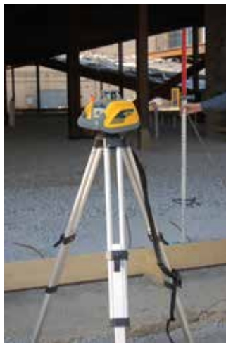
Außenanwendung-Einmessen von Schalungen
