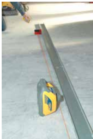
鉛直出し作業
