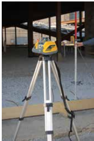
外装作業での設置例
